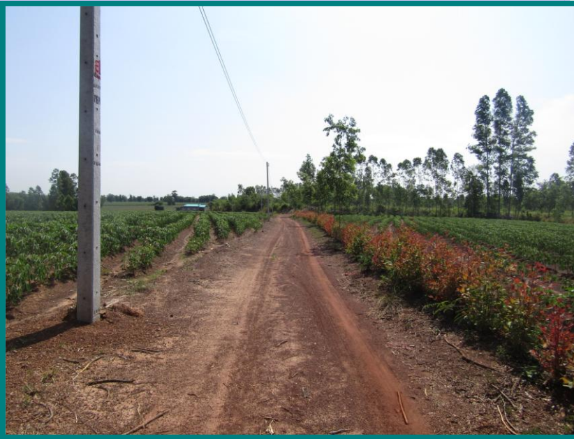
โครงการปรับปรุงถนนลูกรัง หมู่ที่ 10 จากบ้านนายชูชีพ เทพอม ถึงถนนสายบุญเกิด – โคกแจง
